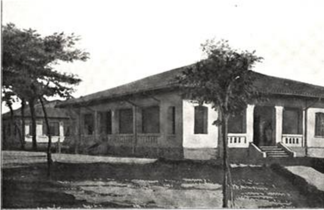
Hôpital de Choquan. — Pavillons des Européens.
